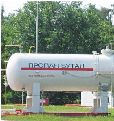
Мал. 96. Ємність із пропан-бутановою сумішшю на автозаправній станції
